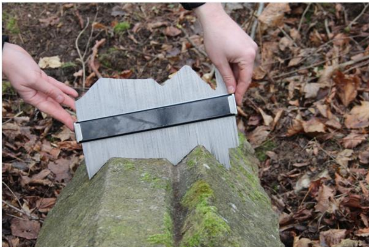
Obr. 7: Při kresebné dokumentaci může být použit speciální hřeben. Sejmутý tvar je následně obkreslen (foto: Archaia Brno o. p. s.).
