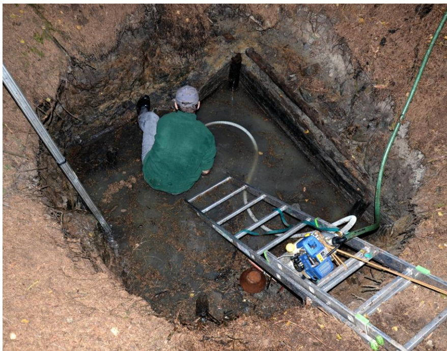
obr. 87. Průzkum šachty u Opatova na Českomoravské vrchovině spojený s odběrem vzorků středověkých výdřev. Foto P. Hrubý.
