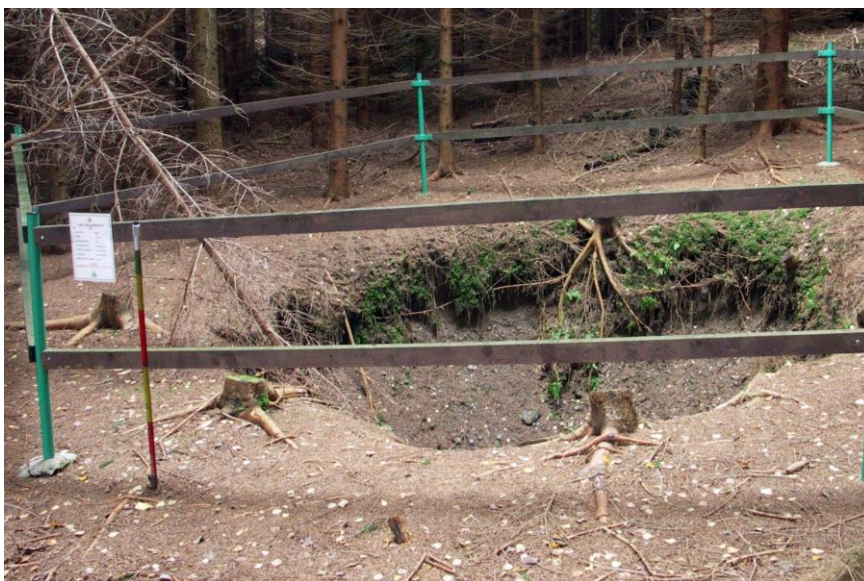
obr. 58. Nově se tvořící propad. Malá Morávka. Foto J.Večeřa 2009.
